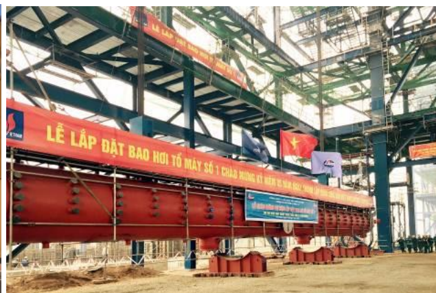
Công trường Nhà máy nhiệt điện Thái Bình 2
