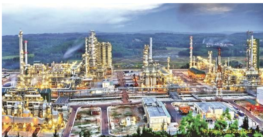
Nhà máy lọc hóa dầu Dung Quất
