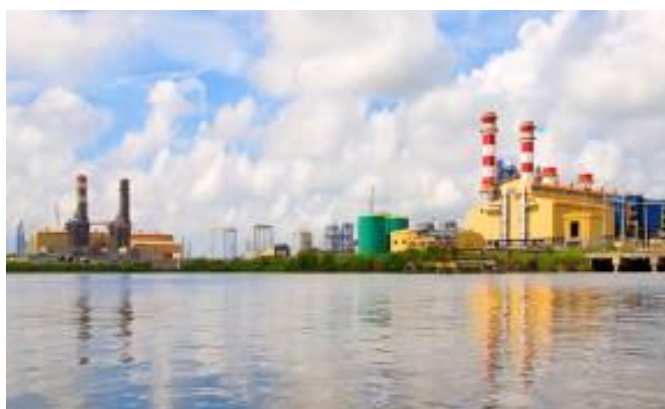
Nhiệt điện Cà Mau 1&amp;2
