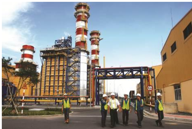
Công trường Nhà máy Nhiệt điện Nhon Trạch 2
