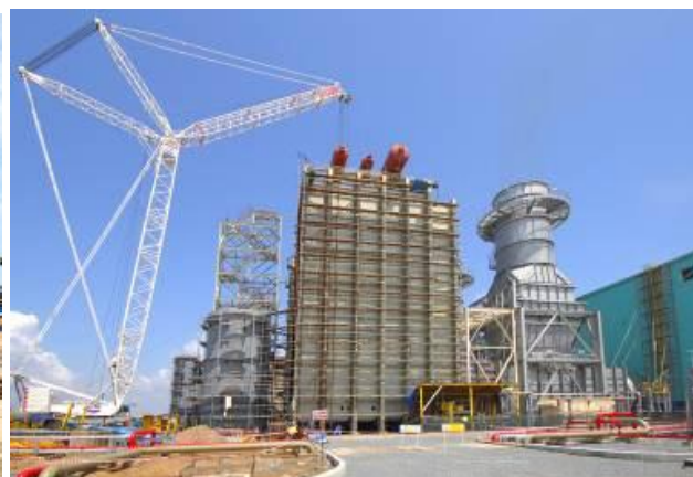
Công trường Nhà máy Nhiệt điện Nhơn Trạch 1
