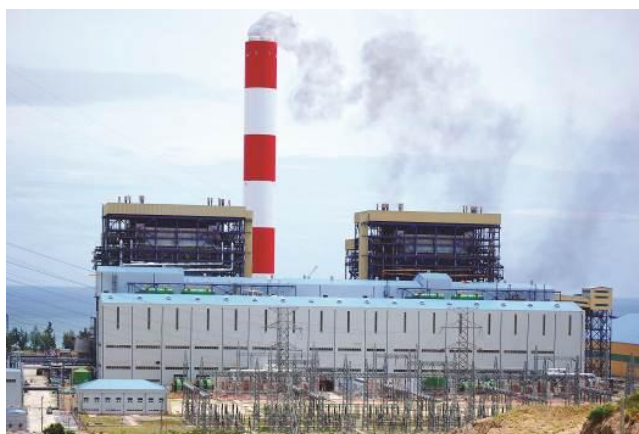
Nhà máy Nhiệt điện Vũng Áng 1
