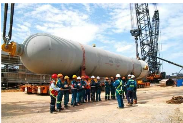
Công trường Nhà máy lọc hóa dầu Nghi Sơn
